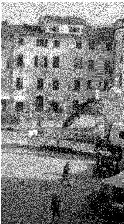
CANTIERE In piazza Matteotti iniziati i lavori per il «Festival»
